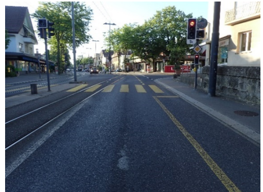
Belagsverformung / Spurrinnen beim Knoten Dorfstrasse
