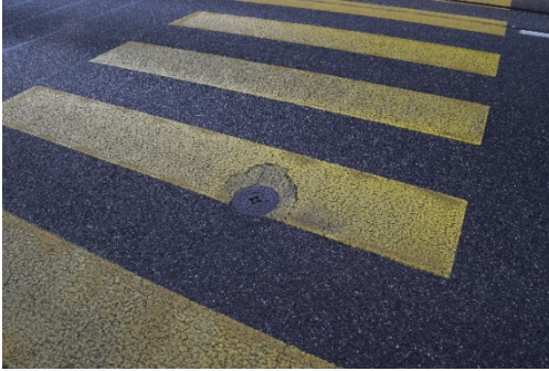
Abnutzung Schieberkappen / Belagsflicke
