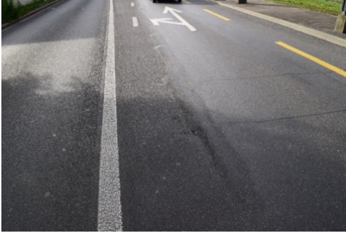
Belagsverformung / Spurrinnen beim Knoten Sandrainstrasse
