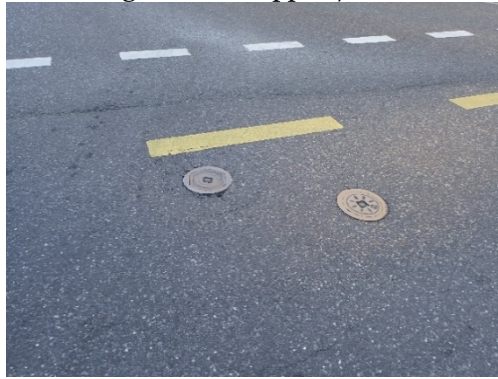
Abnutzung Schieberkappen / Risse rund um Schieber und Schächte
