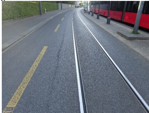
Risse / Senkungen beim Übergang Tramtrogl zum Strassenkoffer
