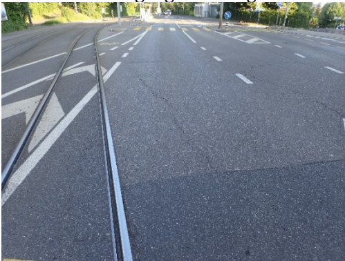
Risse beim Übergang Tramtrog zum Strassenkoffer
