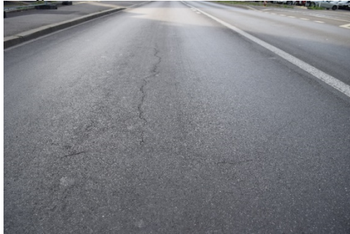
Längsrisse in der Strasse
