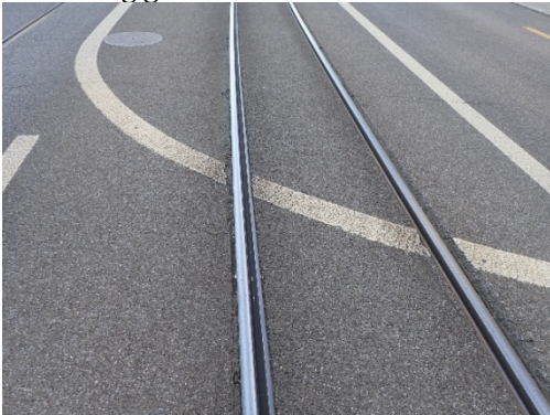
Deckbelag gerissen bei Oberbeton der Gleise
