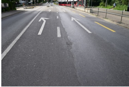
Belagsverformung / Spurrinnen beim Knoten Sandrainstrasse
