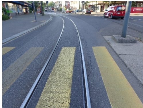
Risse / Senkungen beim Übergang Tramtrogl zum Strassenkoffer
