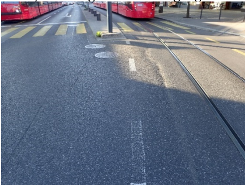
Risse / Senkungen beim Übergang Tramtrogl zum Strassenkoffer
