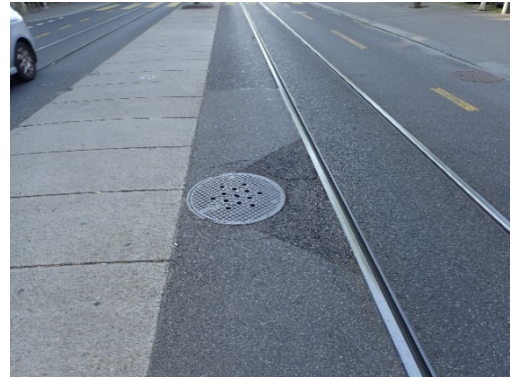
Abnutzung Schieberkappen / Risse rund um Schieber und Schächte
