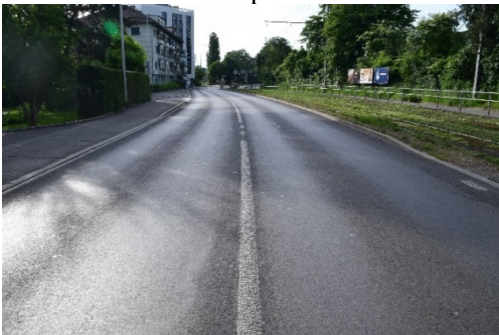
Polieren in der Fahrspur
