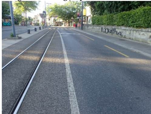
Belagsverformung / Spurrinnen beim Knoten Dorfstrasse
