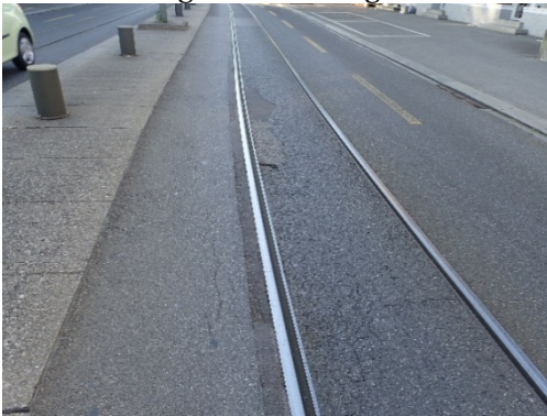
Deckbelag gerissen bei Oberbeton der Gleise
