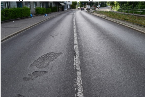
Schlaglöcher im Deckbelag
