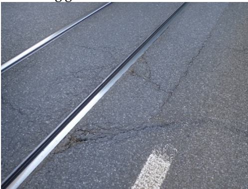
Deckbelag gerissen bei Oberbeton der Gleise
